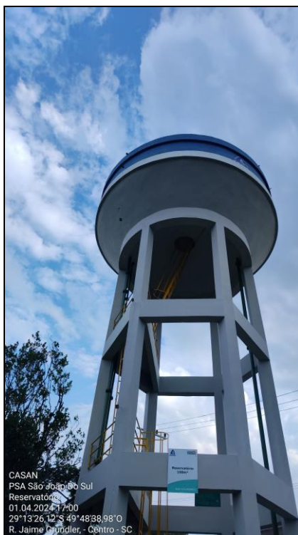
Figura 5 - Reservatório elevado do SAA SJS
