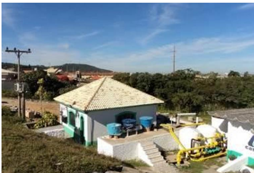
Figura 5 – Vista das edificações da ETA do Machado
