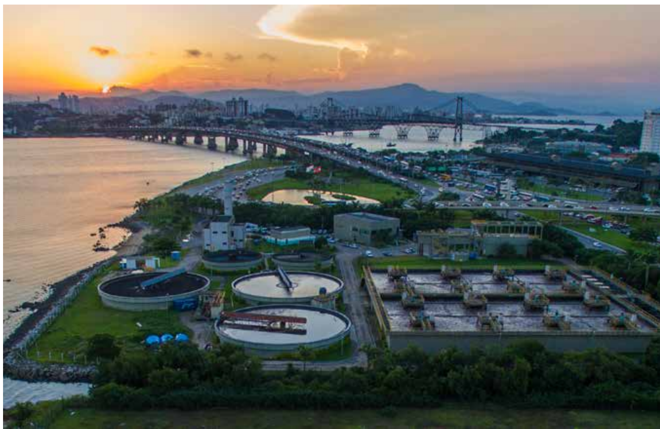
Estação de Tratamento de Esgotos Insular, em Florianópolis: plano de investimentos prevê recursos para construção de outras unidades de tratamento de esgoto e elevação do índice de cobertura de coleta e tratamento no estado.
