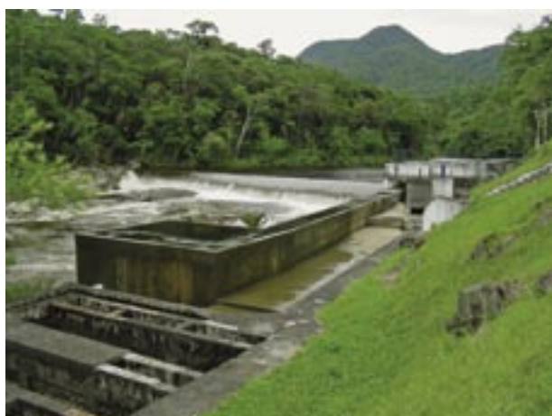
NOVA ADUTORA DO RIO PILÕES VAI BENEFICIAR DIRETAMENTE TODA A POPULAÇÃO DA GRANDE FLORIANÓPOLIS
