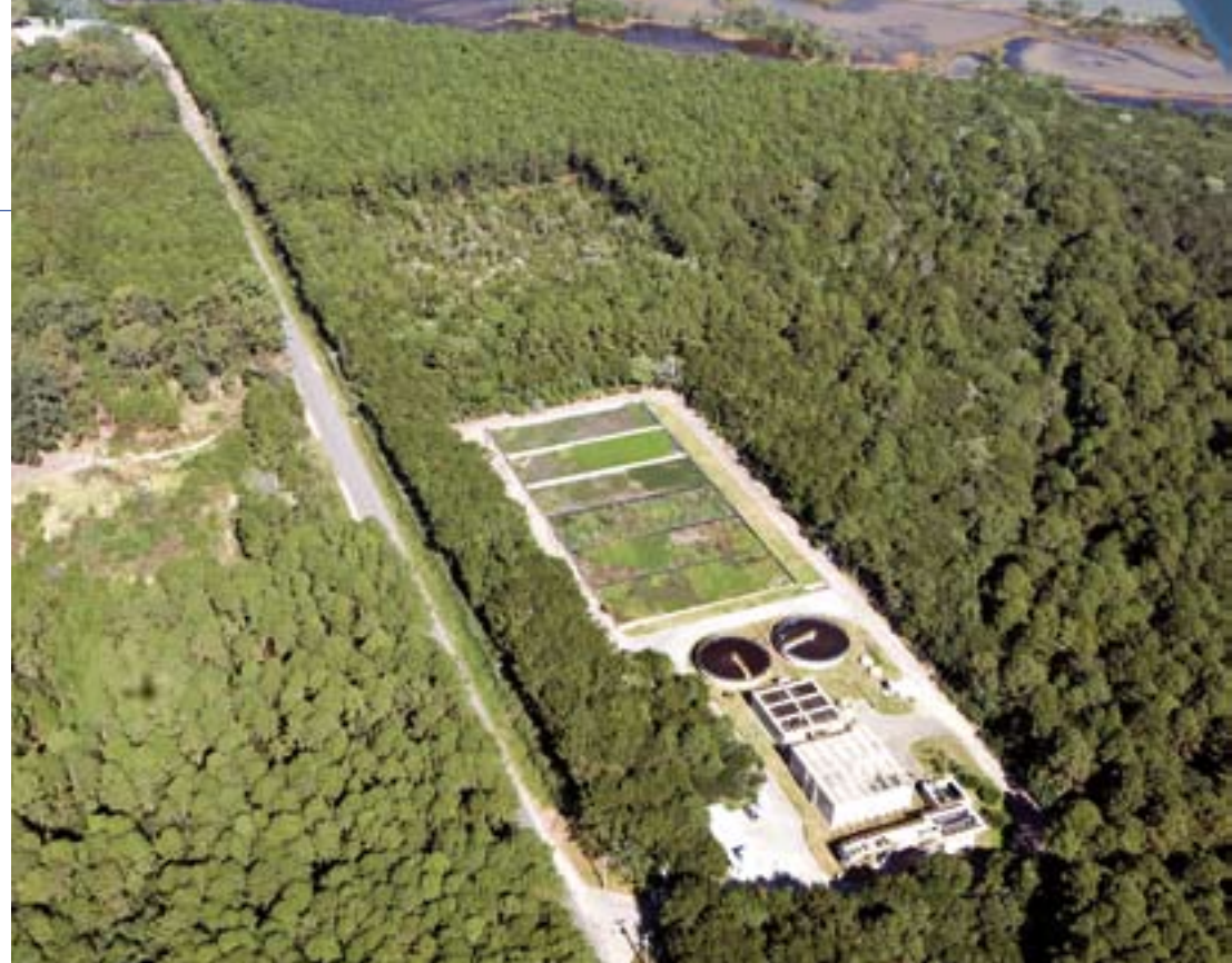
ETE Barra da Lagoa, em Florianópolis: somente em 2008, cerca de R$ 5 milhões foram investidos em sistemas de esgotamento sanitário na Região Metropolitana
