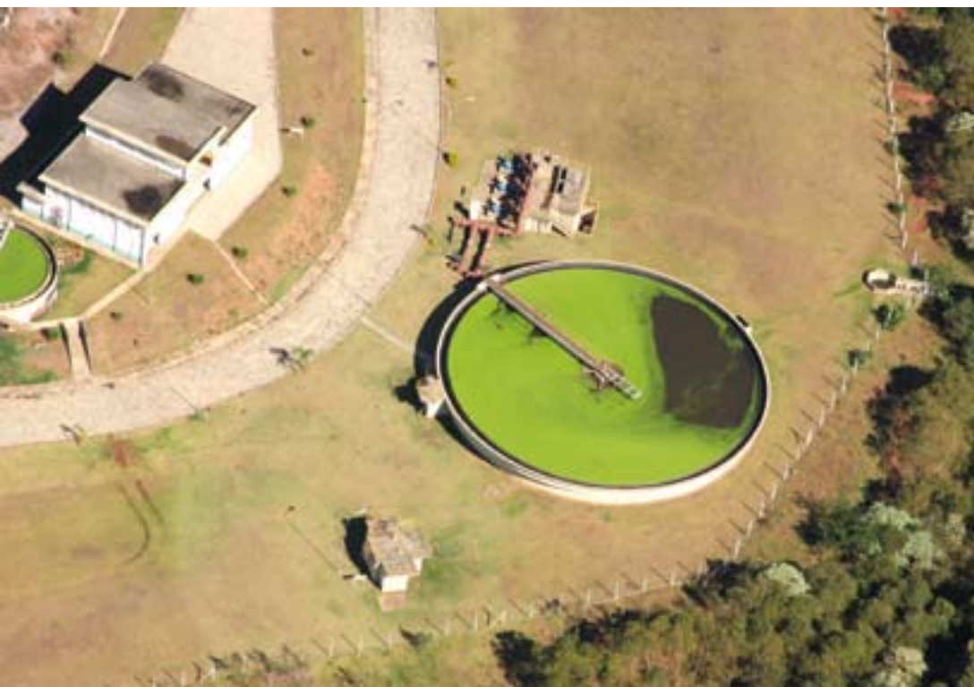
Estação de Tratamento de Esgoto de Chapecó: município adota modelo de Gestão Associada Sewage Treatment Station in Chapecó: the city adopts a model of Associated Management
